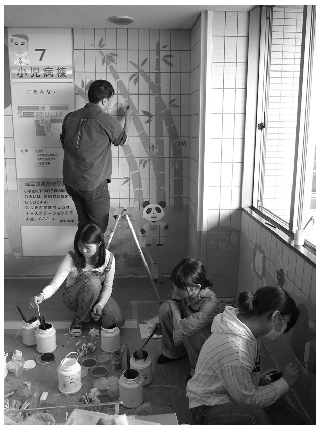
図8. 塗りの作業の様子
