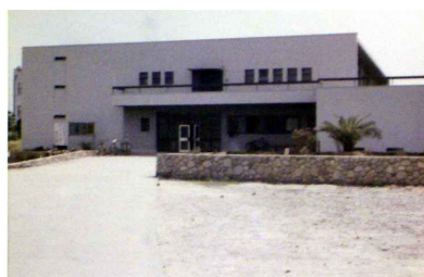
【写真1】 尼崎市立図書館 所蔵：尼崎市立地域研究史料館 総工費 22,795,010円、延面積1,234㎡ 構造 鉄筋コンクリート 2階建・書庫3階建 起工 1958年10月13日 竣工 1959年3月30日 設計 新日本建築家集団大阪支部 管理 尼崎市建設局建築住宅課第一係
