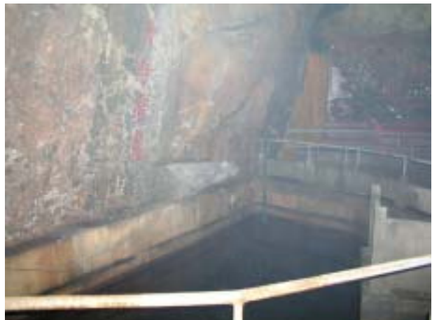
写真7 紫来洞内部の池
