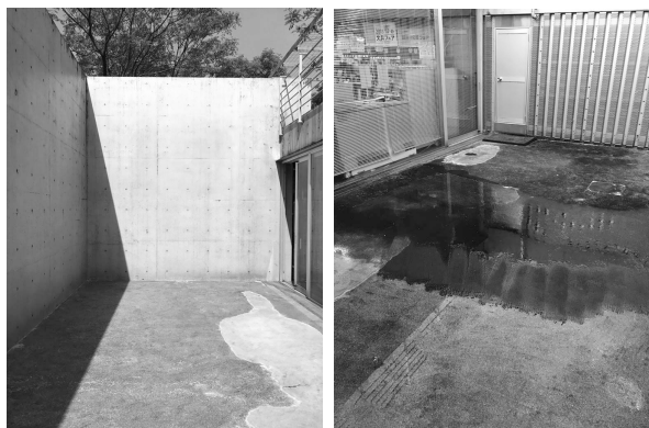
図 7 壁に囲まれたテラス
